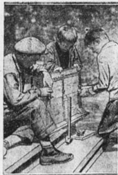
Изучают проводку электричества.
